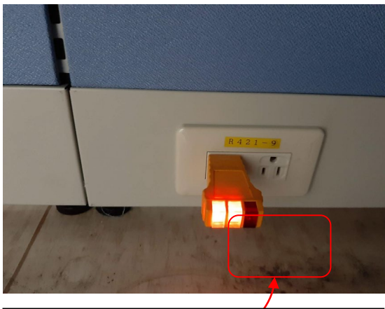
電源插座裝設完成相序極性測試 (蓋板上方 貼迴路標籤)
