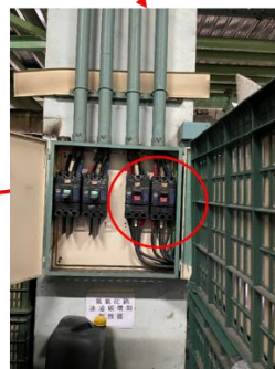
塗裝ED四樓PO4空調(1F冰水機房)
