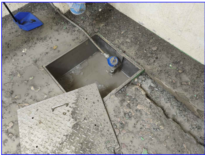
原集液井的防爆液位計樣式
